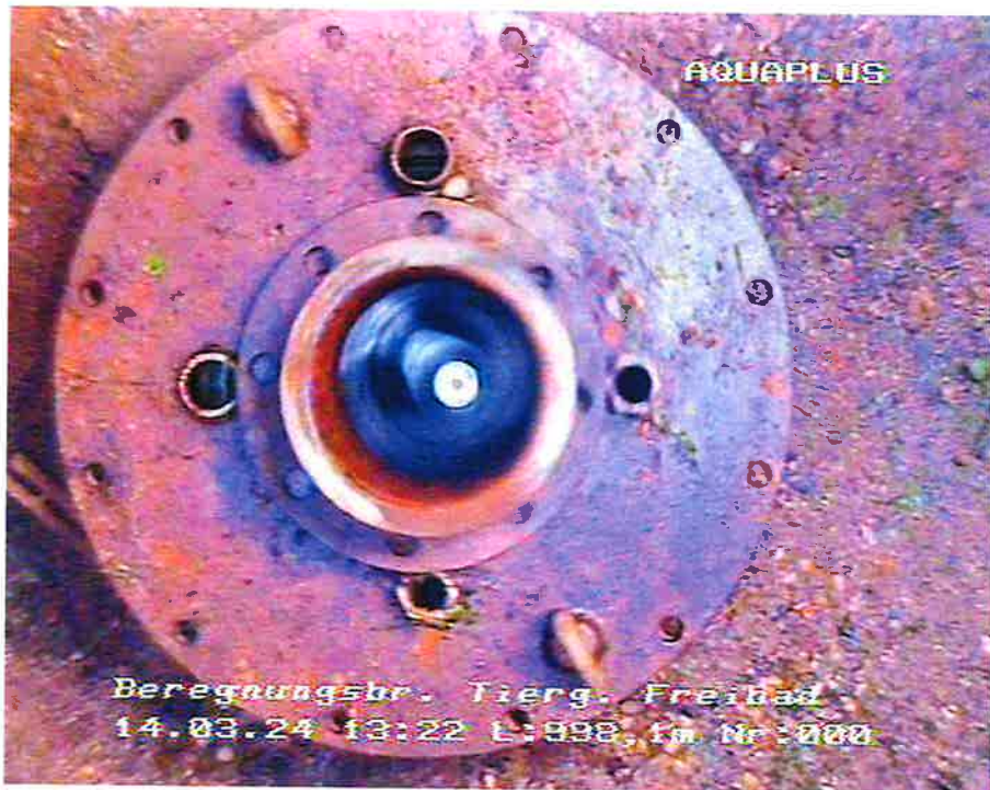
Bild Nr. 1 Im Schacht,
