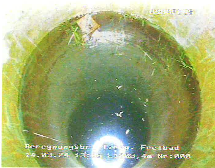
Bild Nr. 5 Tiefe: -8,4 m Im Aufsatzrohr, Blick auf den Wasserspiegel mit kleineren Fremdkörpern
