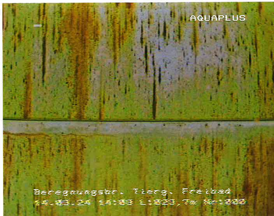
Bild Nr. 15 Filterende, geringe Ablagerungen an der Rohrwand, Blick auf Rohrstoß
