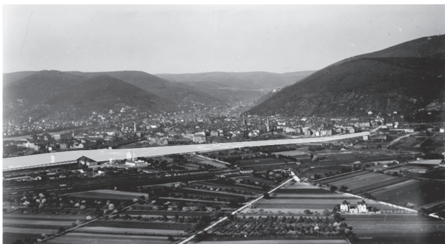
Heidelberg aus der Luft im Jahr 1929: Das Baggerloch umschließt Bergheim und die Weststadt (STAHD).
