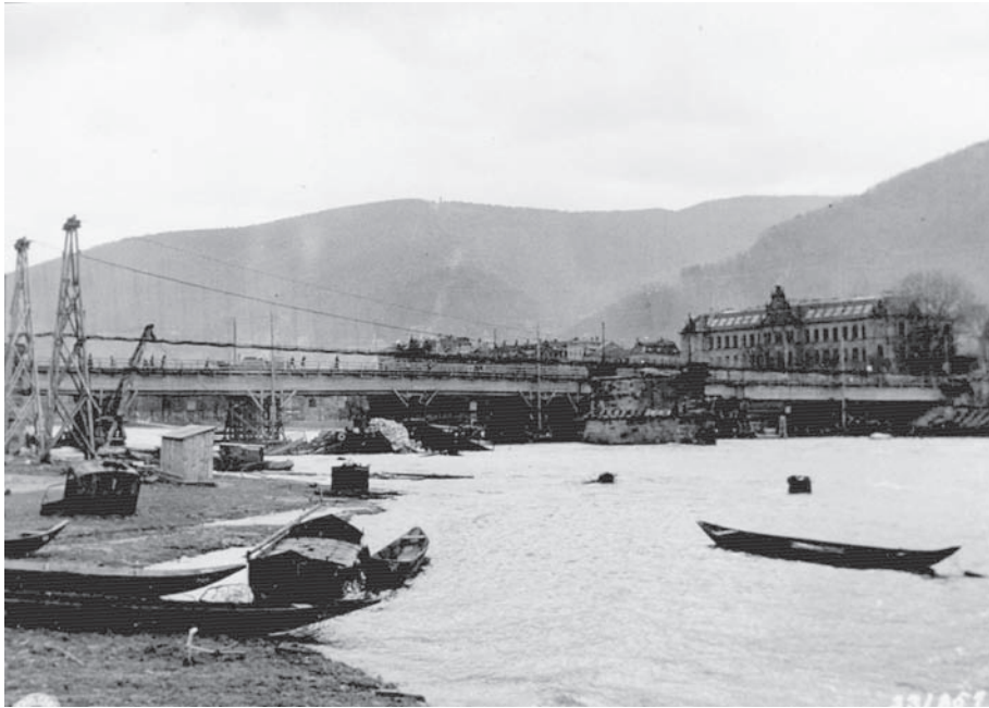
Das von der US-Militärpolizei beschlagnahmte Gebäude des KFG am Neckarstaden und die Behelfsbrücke, der „hölzerne Friedrich“, wahrscheinlich 1945 oder 1946. (Foto: Frank Moraw, reproduzierte Aufnahme des United States Army Signal Corps aus den Beständen der National Archives and Records Administration der USA in College Park, Maryland)
