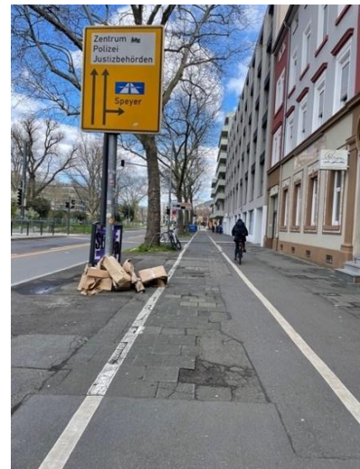
Abbildung 19 – Eine provisorisch eingerichteten Wegführung
