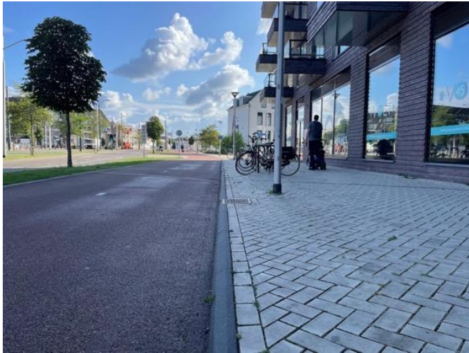
Abbildung 46. Beispiel eines 'verzeihenden Bordes' mit kleinem Absatz, welches eine Trennung sicherstellt, aber gleichzeitig auch die Überquerung ermöglicht (Quelle: Mobycon)
