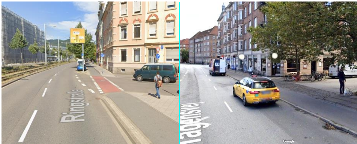
Abbildung 51. Beispiel von Radinfrastruktur die umgesetzt ist mittels Markierung (links) und mittels Aufpflasterung (rechts) – Beispiel aus Kopenhagen, Dänemark (Quelle: Google)
